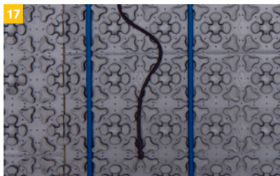
17 Uložte tepelné čidlo mezi dva topné kabely.
