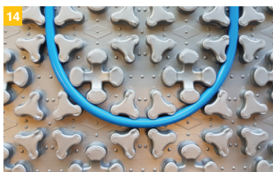
14 Topný kabel vedte vymezovací strukturou kostiček.
