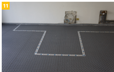
11 Nevytápěné zóny vyznačte před pokládkou páskou.
