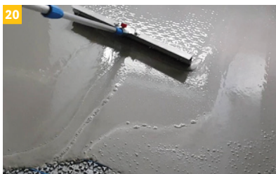
20 Následně naneste na rohož tekutou nivelacní hmotu v minimální vrstvě 5 mm.
