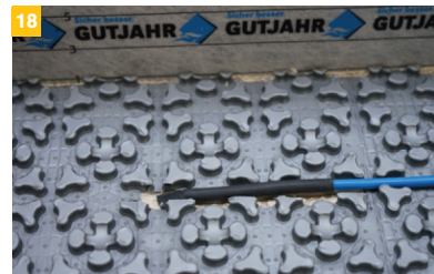
18 Konec topného kabelu uložte do rohože pomocí malého podélného řezu, topný kabel nesmí být krácen. To by vedlo k nefunkčnosti systému!
